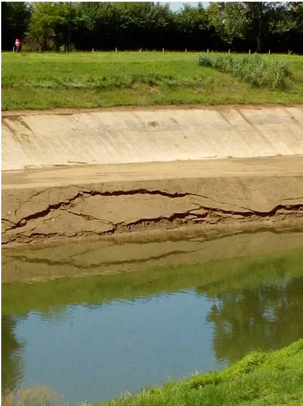
15 maggio 2017, fiume Arno, Firenze, a valle della Pescaia dell'Isolotto Foto di Daniela Burrini Iniziati i lavori di risagomatura degli argini, con evidenti segni di erosione
