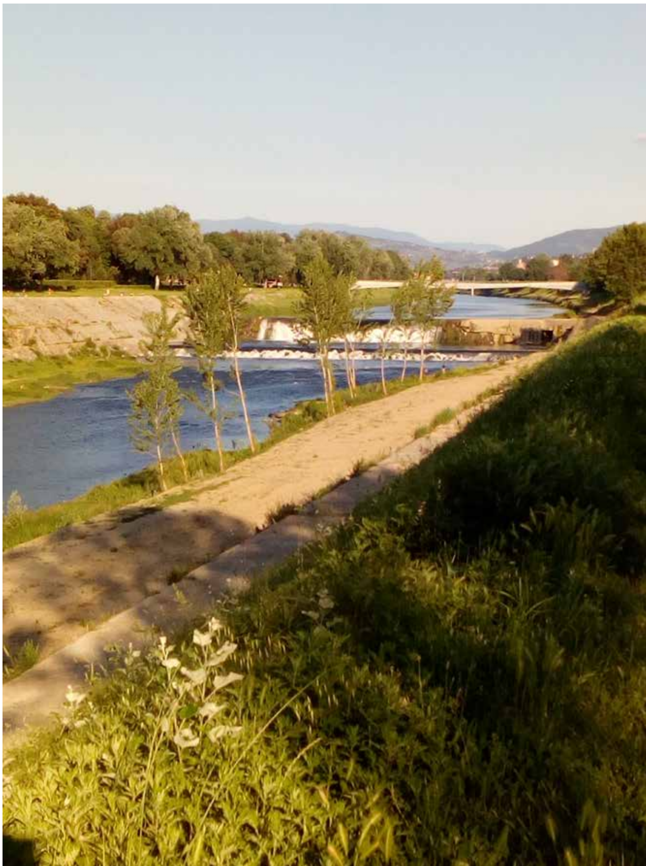
15 maggio 2017, fiume Arno, Firenze, a valle della Pescaia dell'Isolotto Foto di Daniela Burrini Iniziati i lavori di risagomatura degli argini, con evidenti segni di erosione
